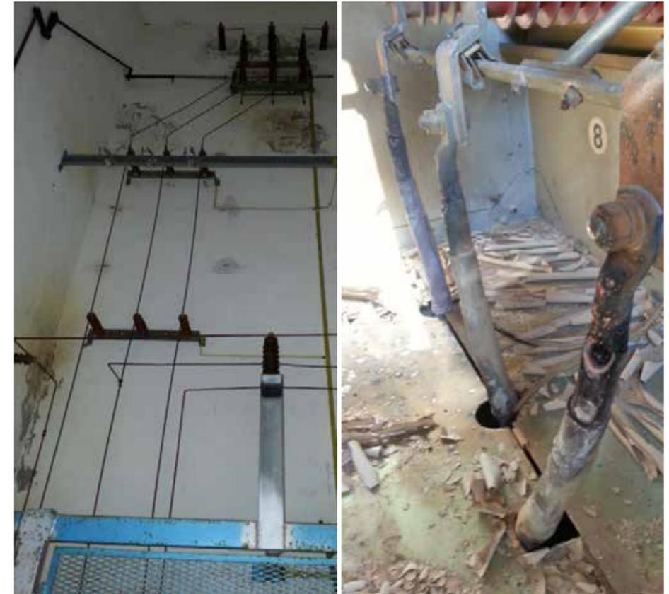
Figura 28 Cabina Utente con problematiche di scariche VS terra
