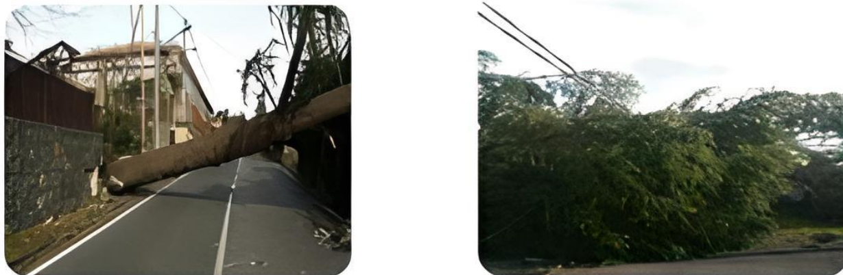
Figura 48- Effetti del vento: Caduta sostegni delle linee aeree e caduta piante
